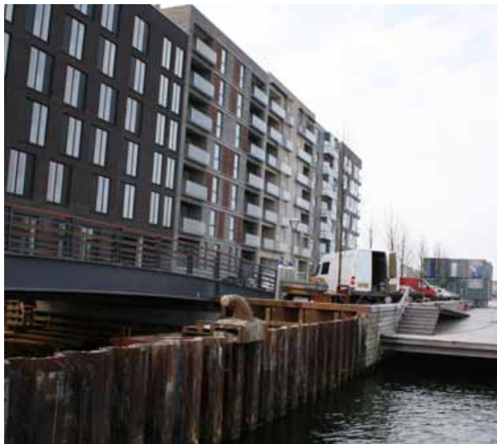
Anlæg af havnefronten ved Teglværksløbet.
