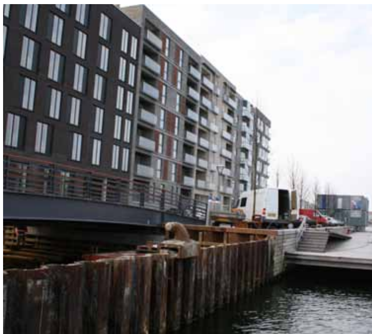
Anlæg af havnefronten ved Teglværksløbet.
